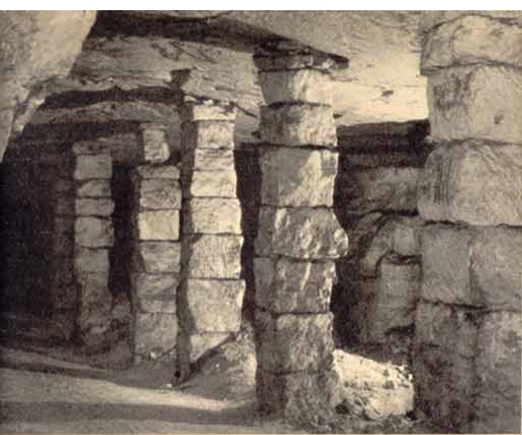
L'exploitation des carrières souterraines de Paris s'est faite par deux méthodes différentes. Tantôt, le banc en exploitation a été intégralement creusé et le toit est alors soutenu à l'aide de pierres entassées les unes en dessus des autres, formant ce que l'on nomme des piliers à bras, tels ceux que l'on voit ci-dessus, dans les carrières situées sous le Val-de-Grâce et communément désignées sous le nom de « Salle des Gardés »...
