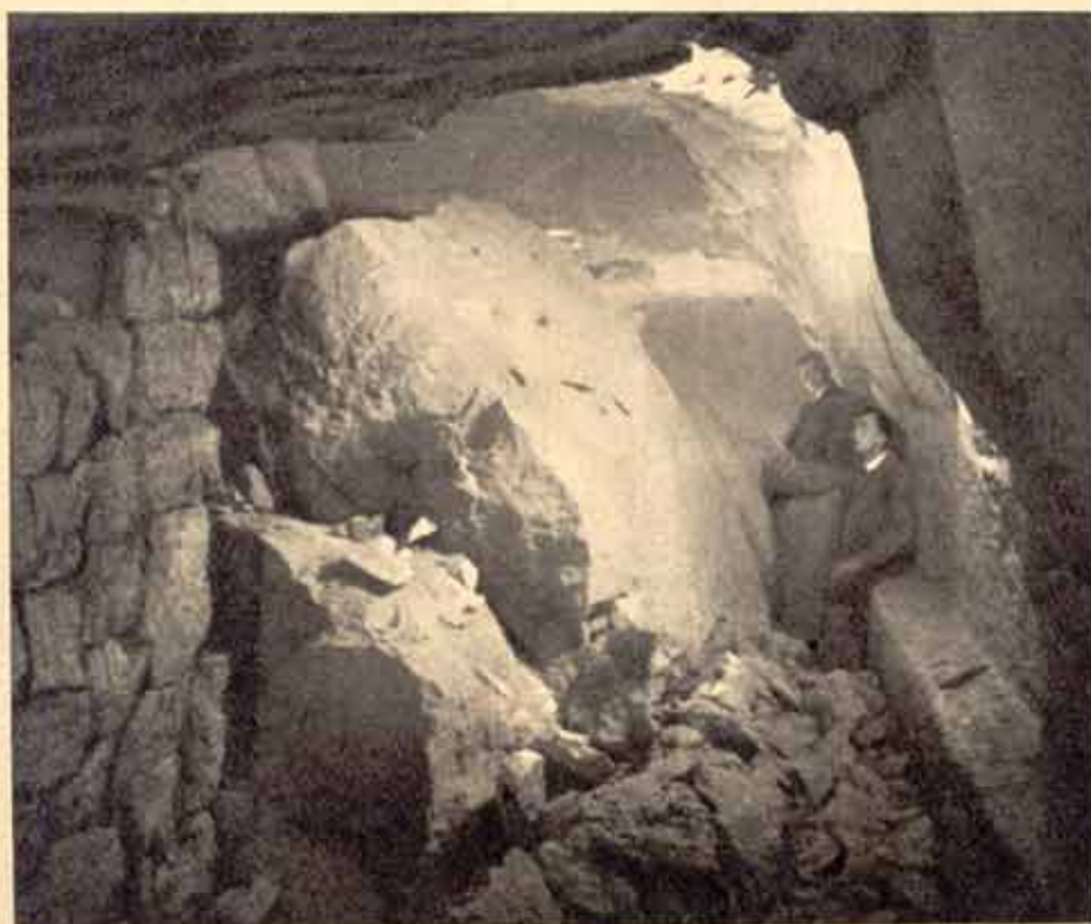
Ci-dessus, le « ciel » vient de s'effondrer et une cloche de fontis apparaît qu'il faudra consolider sous peine de voir se produire, comme sur le cliché ci-dessous, pris dans les anciennes carrières de Châtillon-sous-Bagneux, un affaissement de la voûte.
