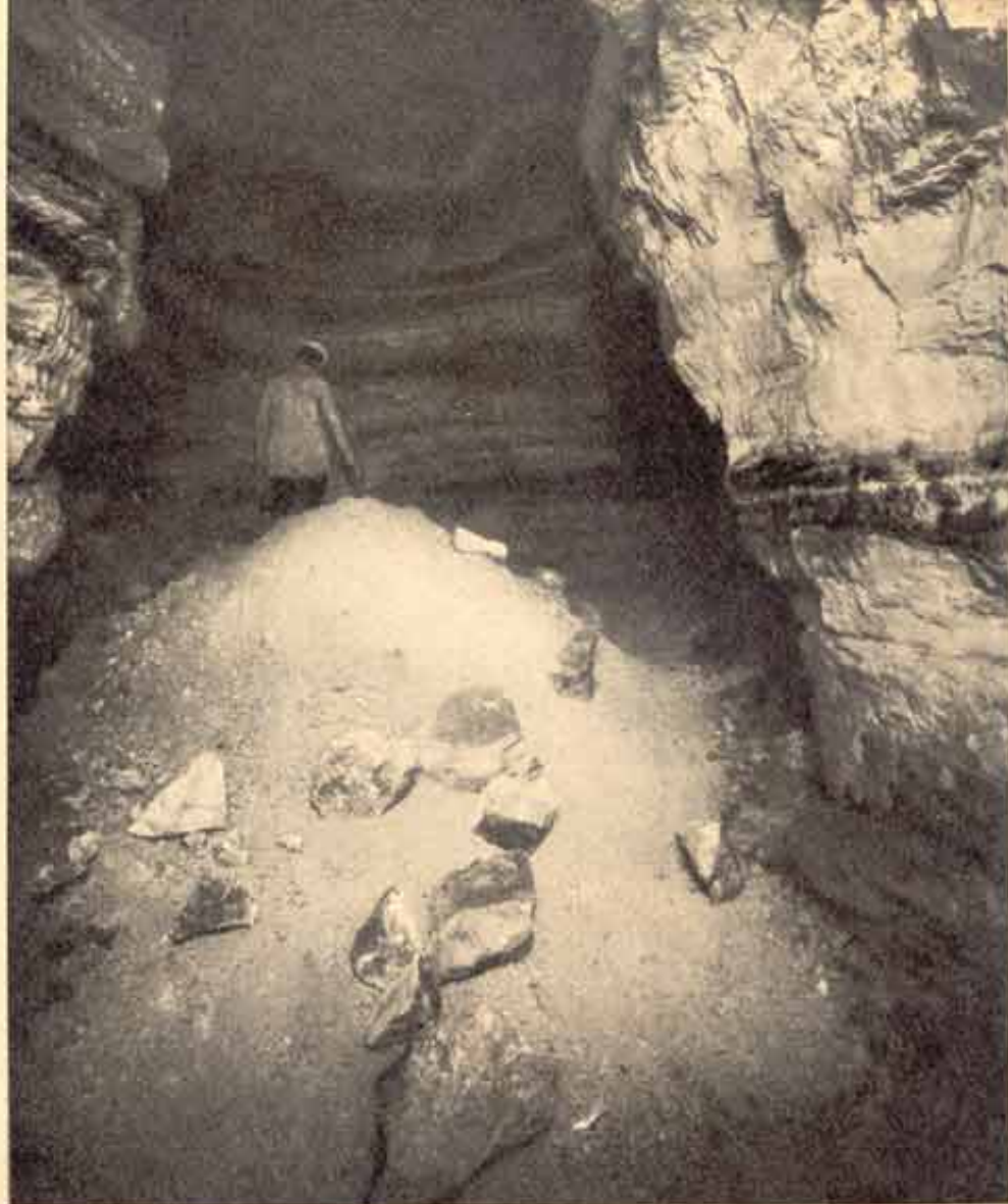
Ci-dessus, le « ciel » vient de s'effondrer et une cloche de fontis apparaît qu'il faudra consolider sous peine de voir se produire, comme sur le cliché ci-dessous, pris dans les anciennes carrières de Châtillon-sous-Bagneux, un affaissement de la voûte.
